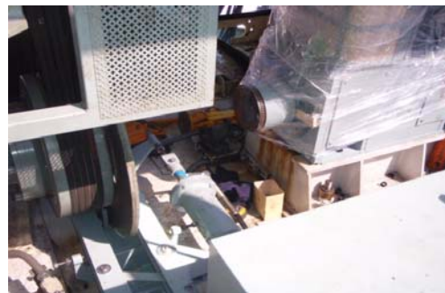
常用ブレーキオーバーホール
