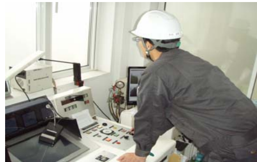
予備原動機を使って搬器を回収する訓練
