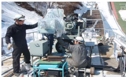
電動機オーバーホール
