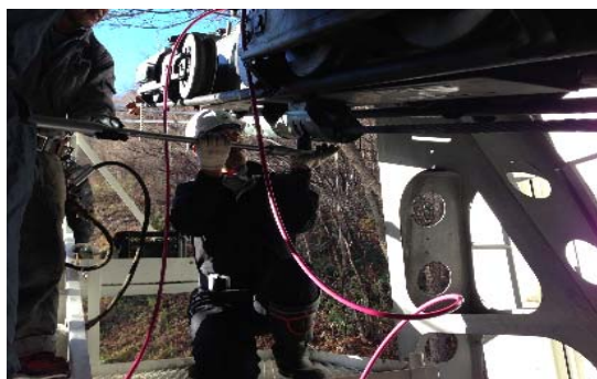
接続装置解体・搬器移動
